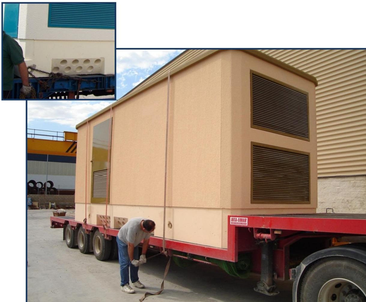
*Sujeción de la pieza sobre camión*
