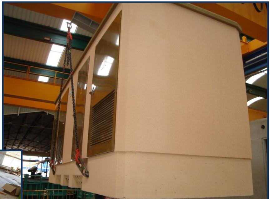
*Izado correcto del edificio: balancín, cadenas y ganchos sobre tacos de madera*
