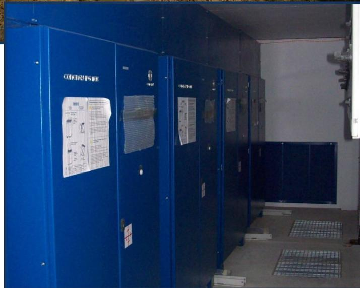
**Configuraciones de envoltentes individuales para huertos solares: C.Inversores**
